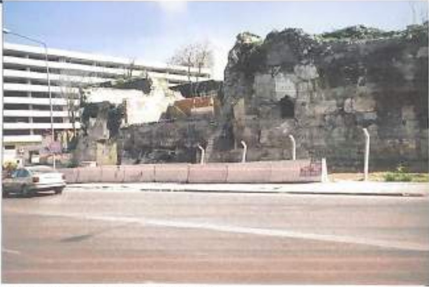
Kalıntıların İkiçeşmelik yolu ile olan durumu
