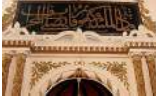
Ödemiş, Küçük (Gürcüzade) Camii
