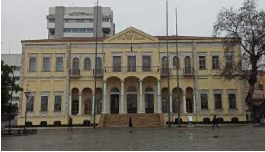
Resim 13: Hükümet Konağı, genel görünüm.
